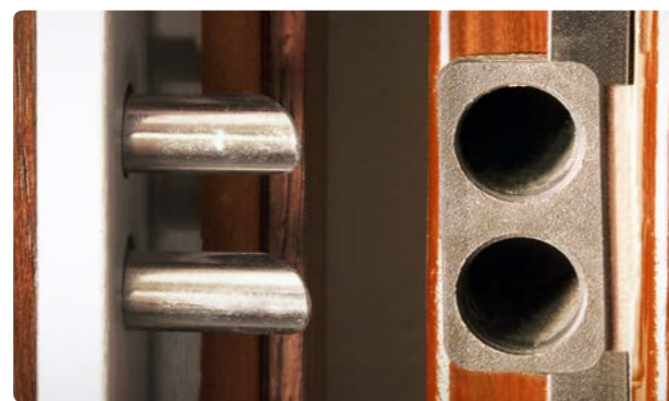
Pouzdra čepů pro původní kovovou zárubeň
